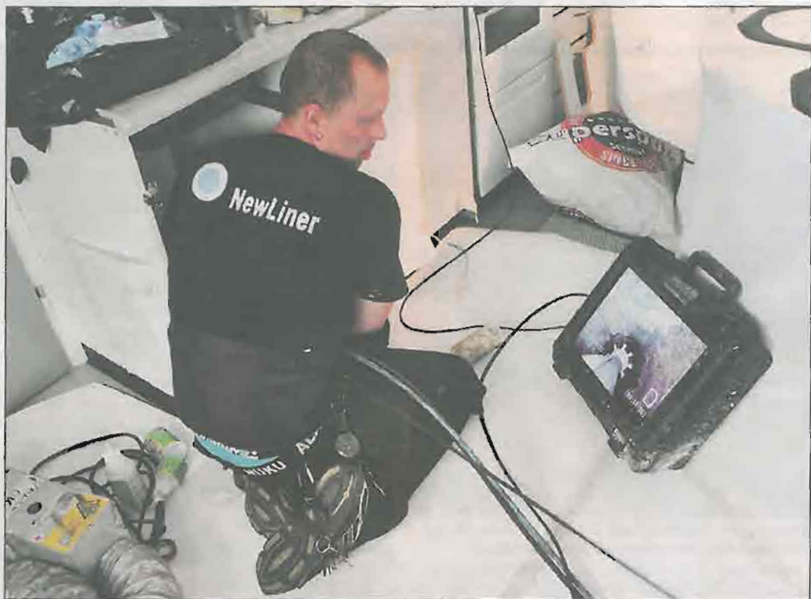
Benny Näsman tarkkailee monitorista viemäriputken sisäistä elämää.
