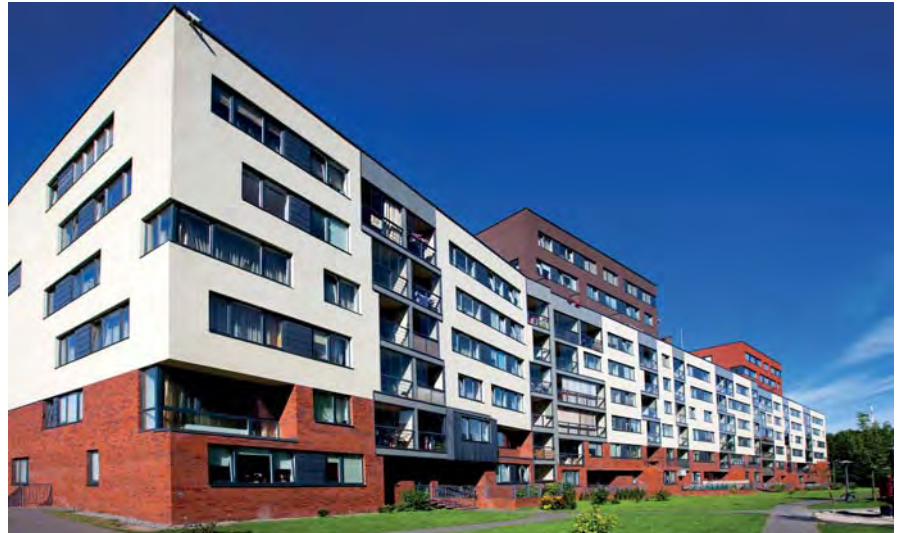
NewLiner on saneerannut tuhansia asuntoja Suomessa, Ruotsissa, Norjassa ja Espanjassa.
