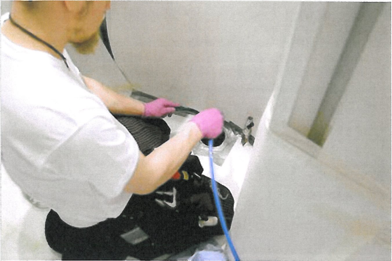
Uudet putket ruiskuvaletaan vanhojen putkien sisälle.
